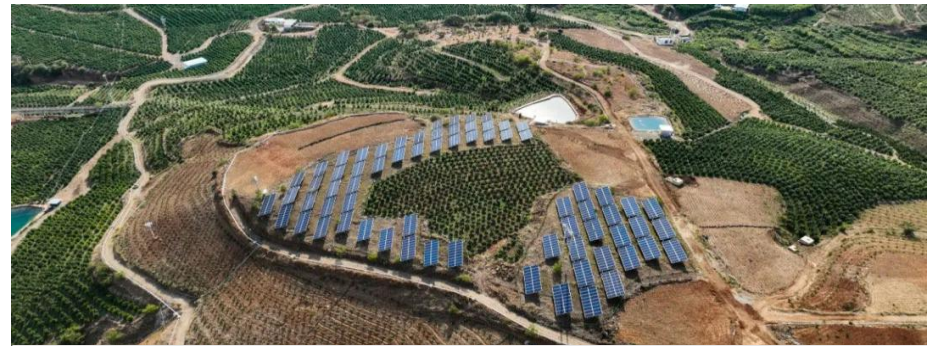
雲南省の太陽光発電型ポンプステーション
